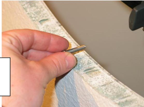
5. Installez le hublot sur le support. Les vis pouvant être serrées à une pression maximale de 2,5Nm.
