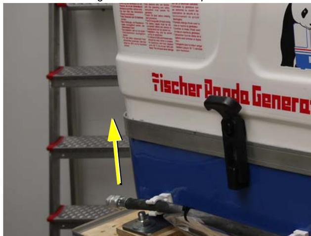
Pour ouvrir le cocon insonorisé, tirez les pattes de fermeture dans la direction de la flèche et soulevez-les. Après l'ouverture de tous les dispositifs de fermeture, la partie supérieure du cocon peut être séparée de la partie inférieure par soulèvement.
