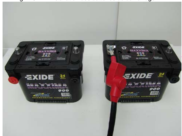
Fig. E.8.4-1: Installation des batteries de démarrage 24 V
