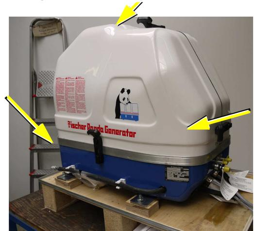
Pour ouvrir le cocon insonorisé, tirez les pattes de fermeture dans la direction de la flèche et soulevez-les. Après l'ouverture de tous les dispositifs de fermeture, la partie supérieure du cocon peut être séparée de la partie inférieure par soulèvement.
