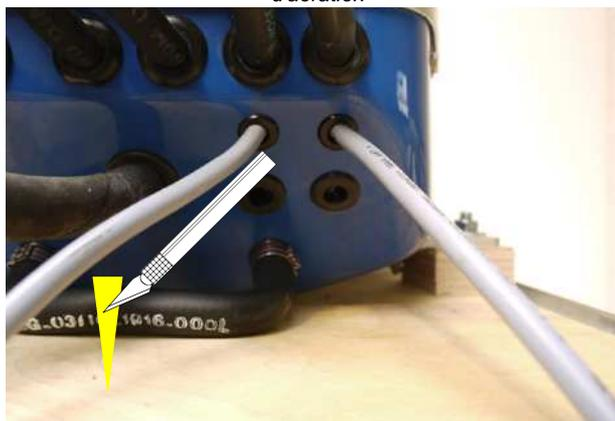
Fig. 5.3.5-2: Le tuyau en caoutchouc sectionné est ensuite coudé vers le haut
