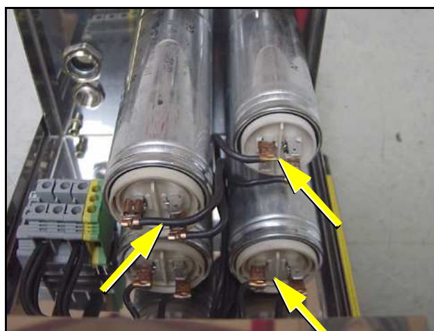
Fig. D.4.1-1: Capacitor
