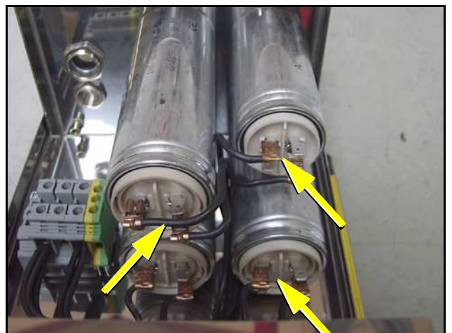
Fig. E.4.1-1: Capacitor
