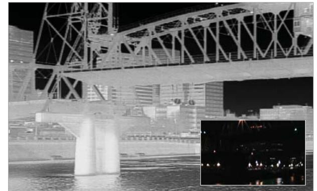
Image thermique de la structure d'un pont, de nuit et ce que l'oeil humain voit (incrustation)
